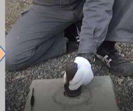
③ (パイプ切断部矯正) カットしたパイプの穴を矯正ユニット「たたき」で矯正します
