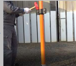
⑦ (支柱挿入) 矯正ユニット「ダゲキ」を装着しハンマーにて柱を標識ツナグッドにたたき入れます
