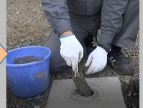
④ (モルタル注入) モルタルを注入します
