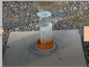
⑥ (標識ツナグッド挿入確認) 下まで挿入し水平確認します
