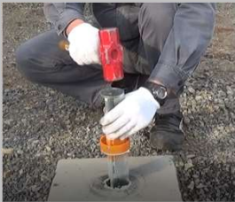
⑤ (標識ツナグッド挿入) 標識ツナグッドをたたいて挿入します
